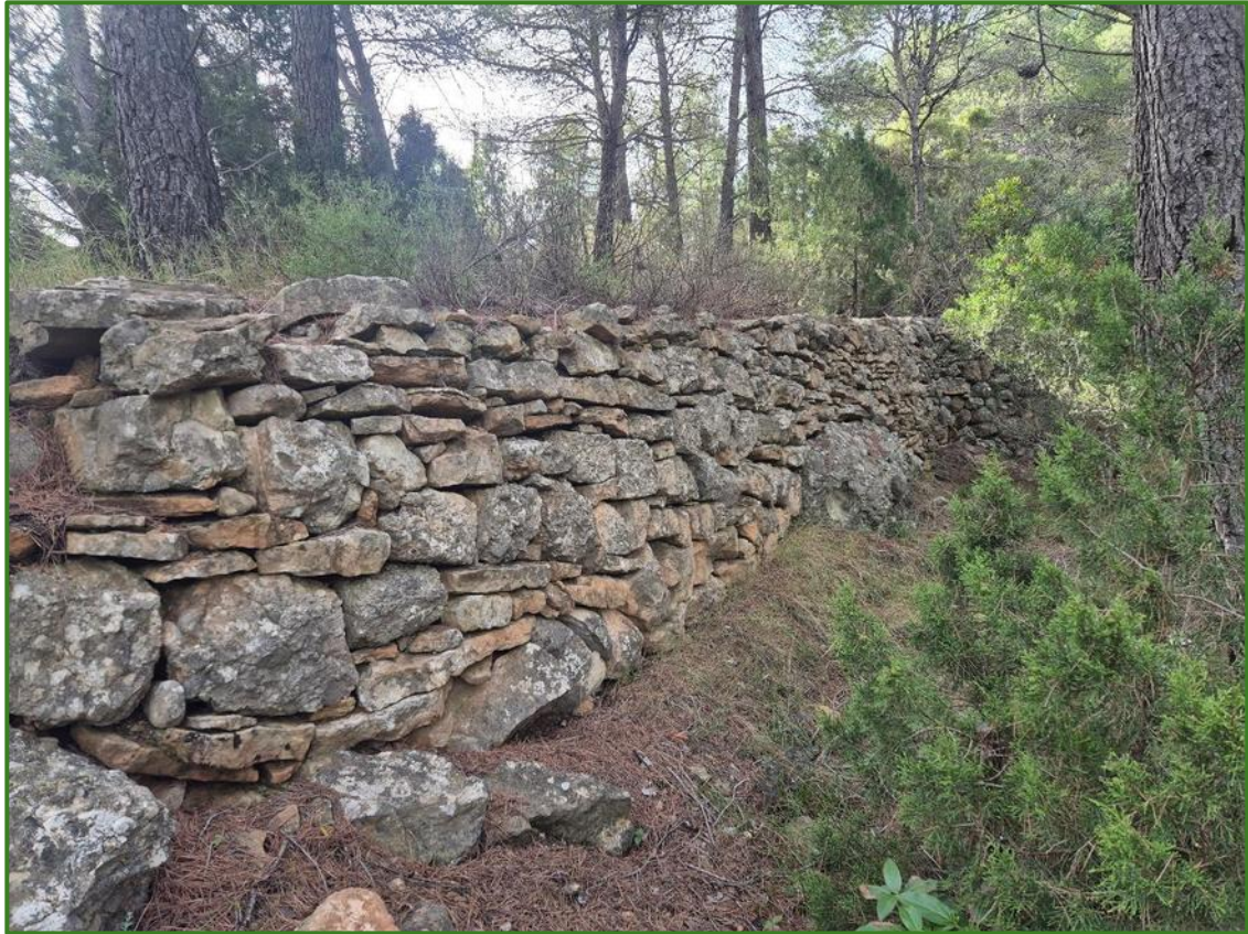
Il·lustració 36: Mur de pedra en la parcel·la d'inventari nº12 (Font: Belda Ingenieros SL)
