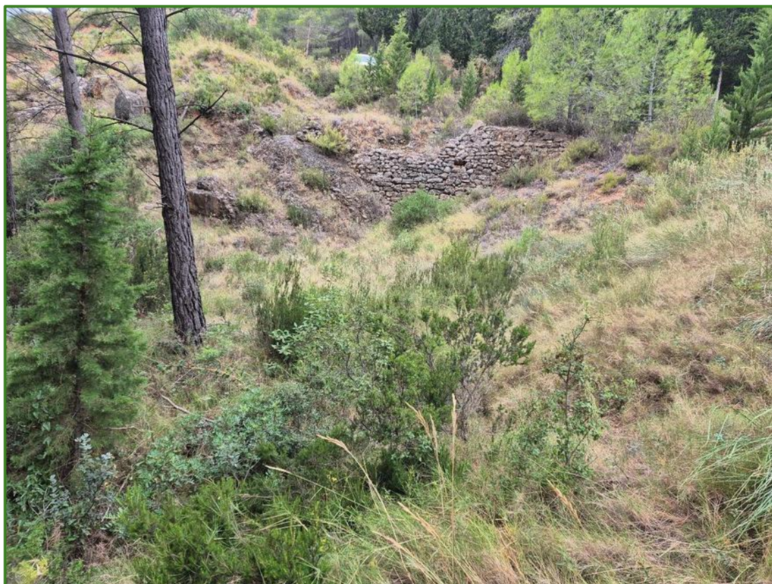
Il·lustració 28: Mur de pedra en la parcel·la d'inventari nº4 (Font: Belda Ingenieros SL)
