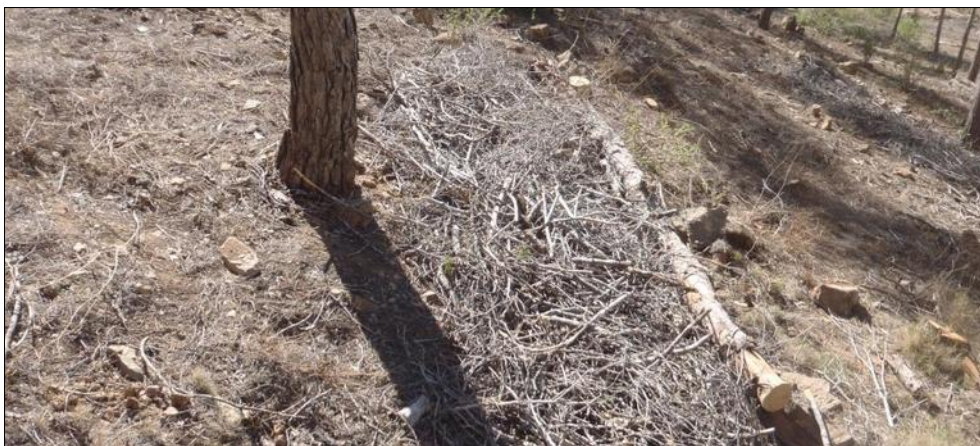
Il·lustració 31. Feixina de fusta amb rastell de branques. Font: Belda Ingenieros S.L.
