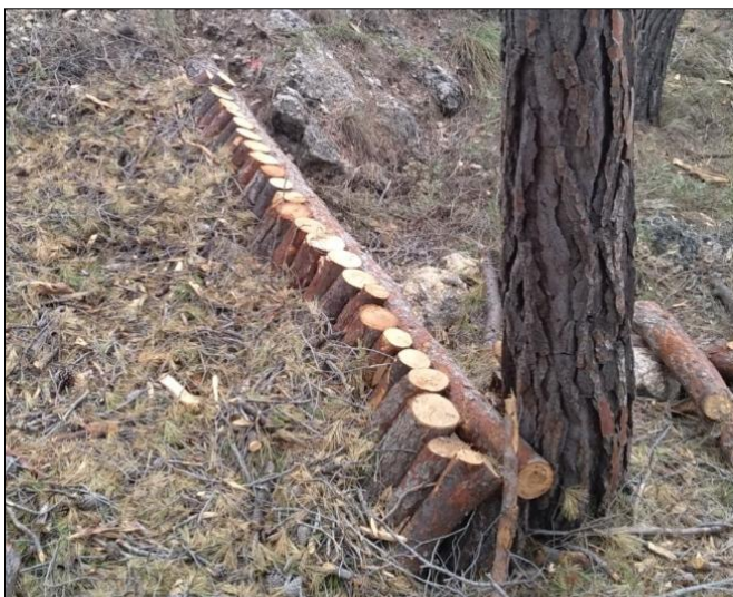
Il·lustració 30: Rastell construït en petits barrancs gestionats. Font: Belda Ingenieros S.L.
