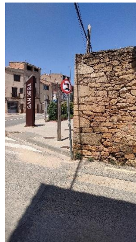
Imatge 4. Carrer Povet de la Plana, senyal vertical en mal estat i no reglamentària.
