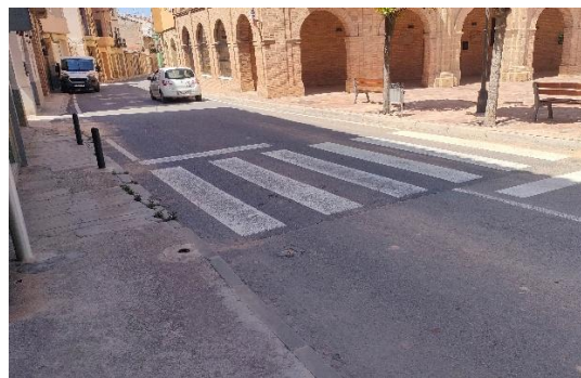
Imatge 10. Carrer de Sant Miquel. Pas de vianants amb senyalització horitzontal correcta.
