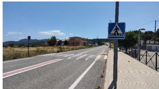
Imatge 49. Pas de vianants elevat existent entre el carrer Quinze i el camí del Coll de la Font.
