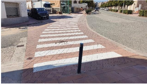
Imatge 11. Avinguda Catalunya, pas de vianants massa llarg i que caldria escurçar.
