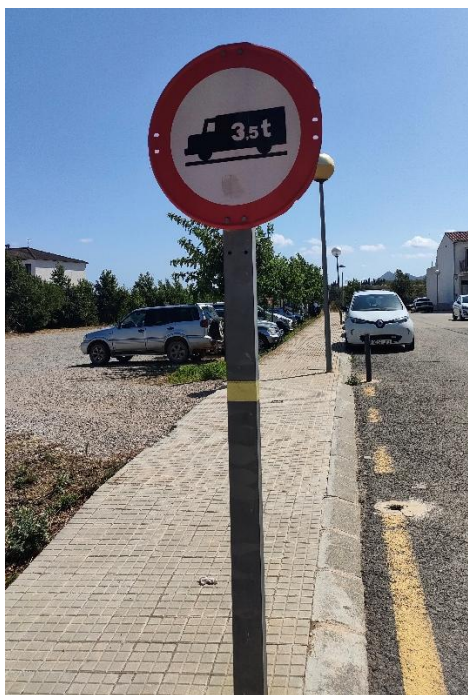
Imatge 5. Carrer del Mestre Joan Garde, senyal de limitació de càrrega no reglamentària.
