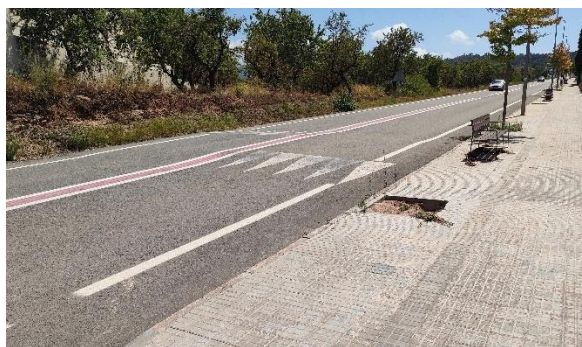
Imatge 15. Avinguda Franquet, ressalt amb reducció de l'amplada del carril.
