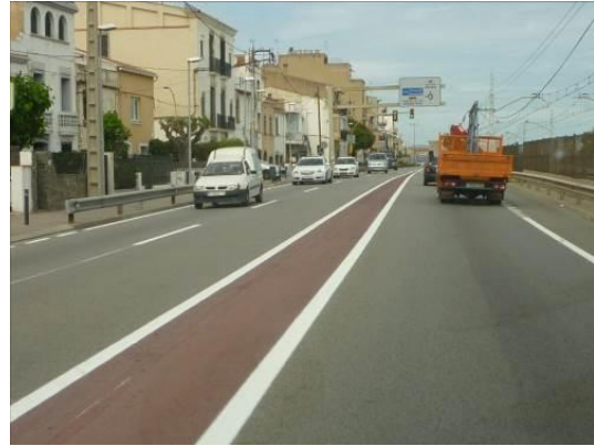
Imatge 63. Exemples de mesures de fàcil aplicació per l'estretament d'amples de calçada
