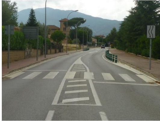
Imatge 63. Exemples de mesures de fàcil aplicació per l'estretament d'amples de calçada
