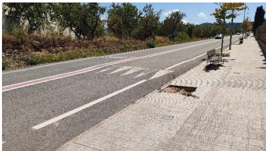
Imatge 48. Ressalt i reducció del carril de circulació a través de mitjana pintada abans d'arribar a la urbanització.
