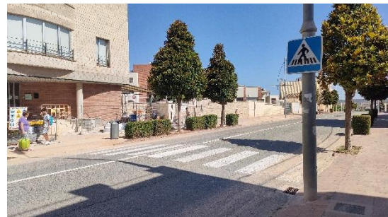
Imatge 57. Pas de vianants elevat existent vist des del costat est de l'Avinguda Catalunya.
