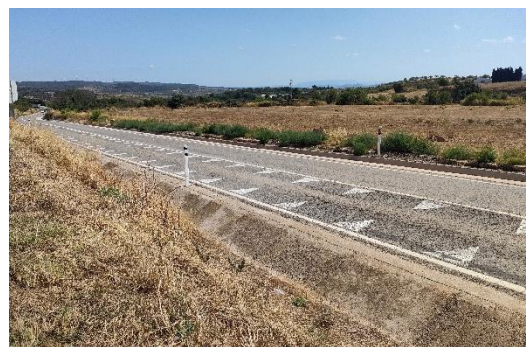
Imatge 16. Avinguda Catalunya. Mesures de reducció de velocitat a l'entrada al poble.
