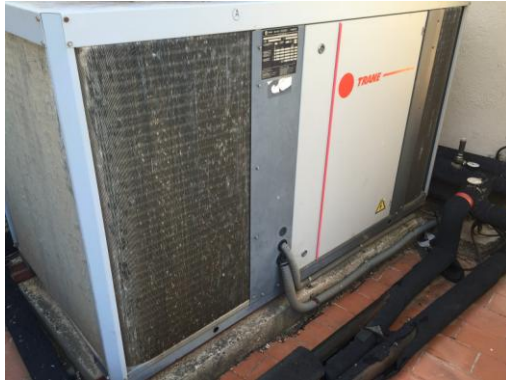
Figura 5. Bomba de calor aire- aigua
