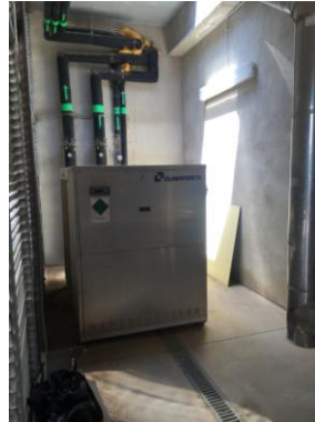
Figura 6. Bomba de calor aigua- aire
